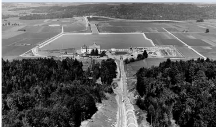
Das Leitzachkraftwerk 2 mit Unterwasserbecken und Fallrohr nach Fertigstellung der Erweiterung im Jahr 1961 (Stadtarchiv München)
